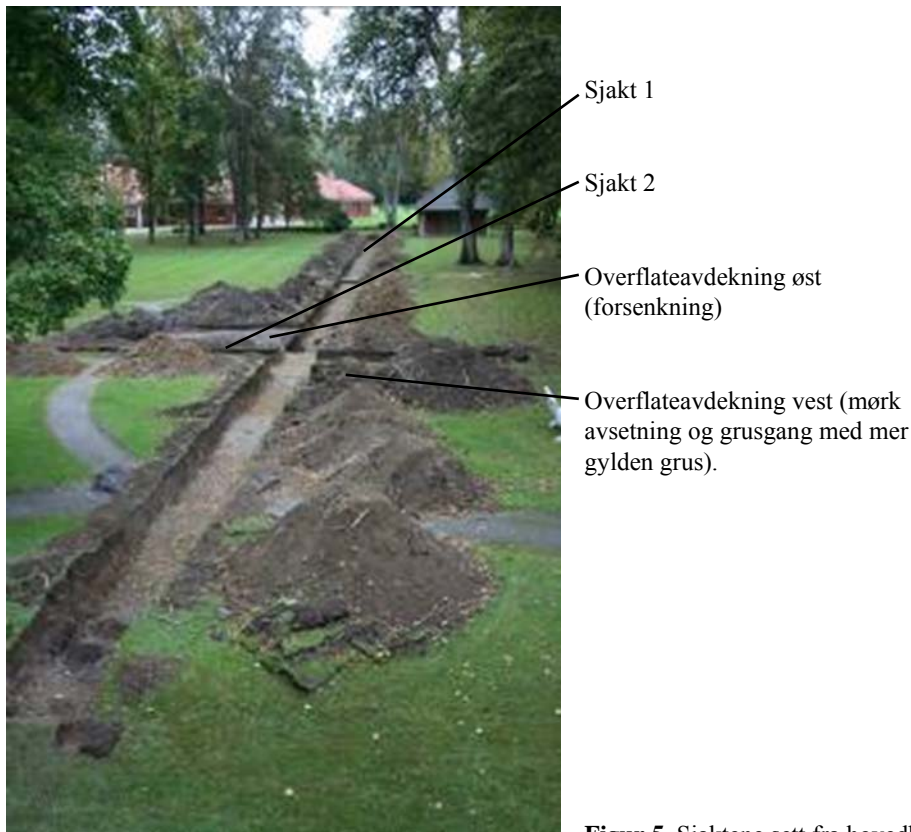
Figur 5. Sjaktene sett fra hovedbygningen.
