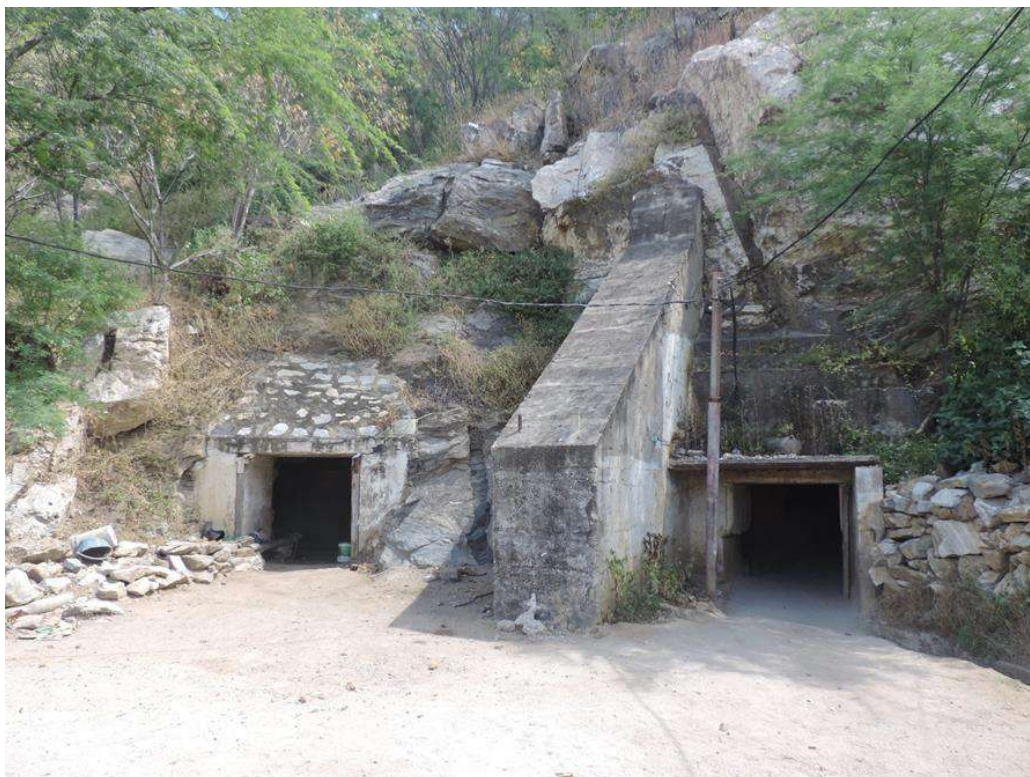
Figura 5.24 – Entradas de galerias de exploração no Geossítio Mina Brejuí.
