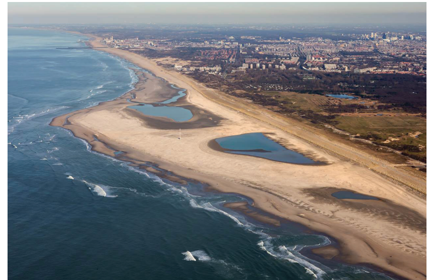
Figure 6: Sand motor (Credit: Rijkswaterstaat / Jurriaan Brobbel).
