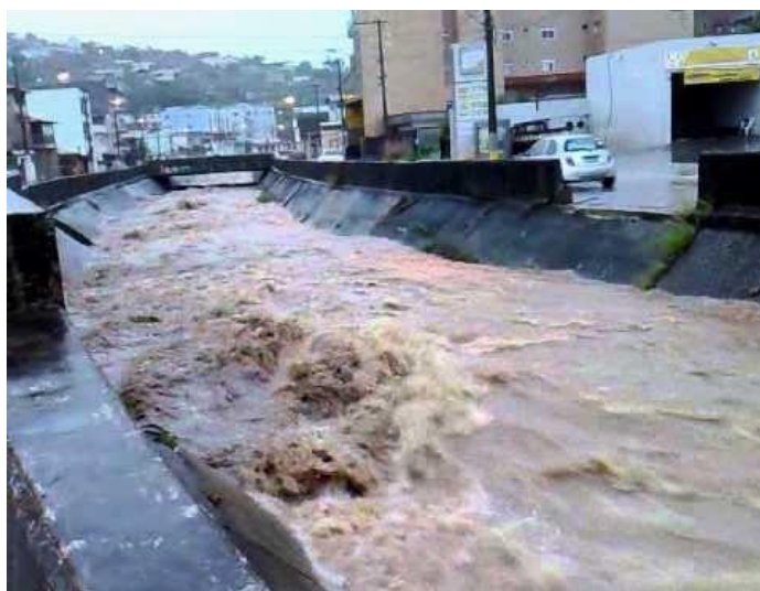
Figura 3: Corrégo da Rua Bahia atualmente, em foto de 2019. Nesse dia, um alagamento provocou muitos problemas na região. Acúmulo de lixo foi notado nos cursos de água que nutrem o córrego. A ausência de cobertura vegetal e o estabelecimento de canais de concreto são aspectos que aumentam as chances de desastres não naturais. Fonte: Barbacena Online (2019).
