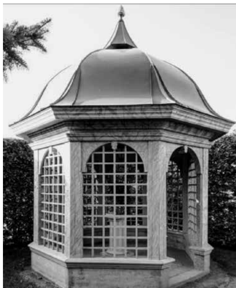
2 pav. Medinė pavėsinė, imituojanti marmurinį statinį. Rundalės rūmų parkas, Latvija
