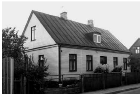
5 pav. Medinis XX a. pradžioje–viduryje statytas gyvenamasis namas po renovacijos plastikinėmis dailylentėmis. Teatro g., Panevėžys
