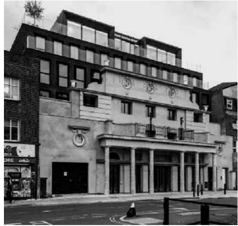
3 pav. Medinis komercinis gyvenamasis namas Pitfield gatvėje Londone. Naujo statinio priekiniam fasadui panaudotas čia anksčiau buvusio „Hoxton“ kino teatro frontonas, archit. „Waugh Thistleton Architects“, 2018 m.
