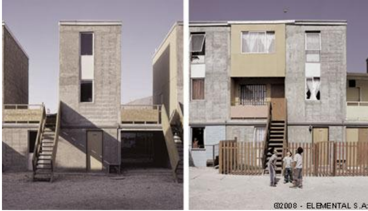
Presentación 12: Proyecto en Iquique, Chile. A la izquierda vemos las habitaciones listas para ser entregadas a sus futuros habitantes. A la derecha las mismas “completadas” por sus habitantes.
