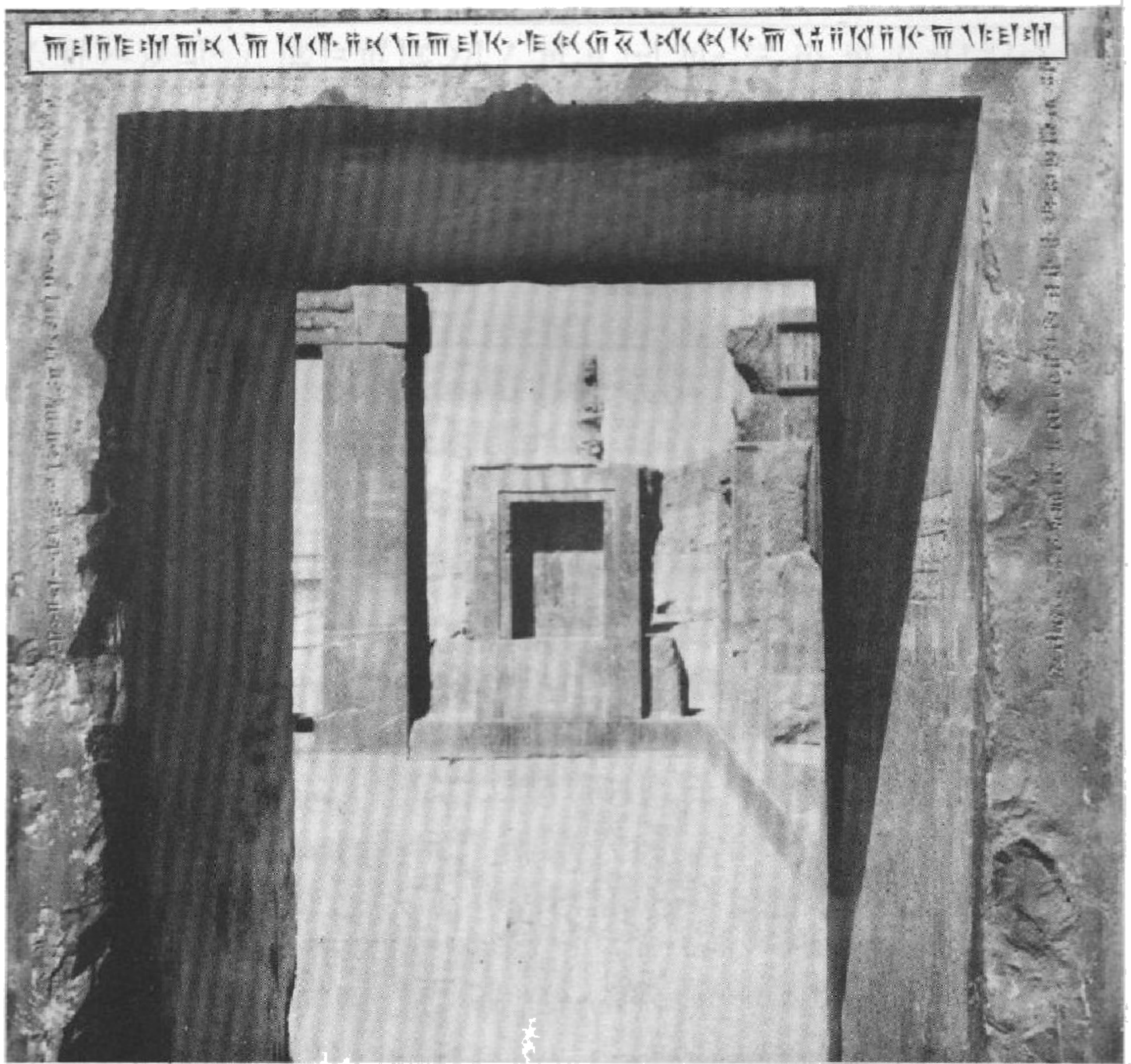
دریچه سنگی که از یک پارچه سنگ تراشیده شده در کاخ خصوصی داریوش کبیر در تخت جمشید . یکی از ستونهای کاخ آپادانا پداست.
