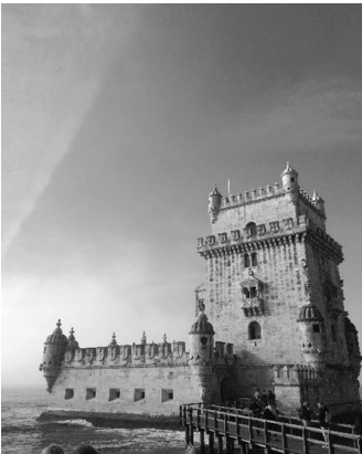
Larawan 18. Torre ng Belem sa Lisbon, Portugal (2018)
